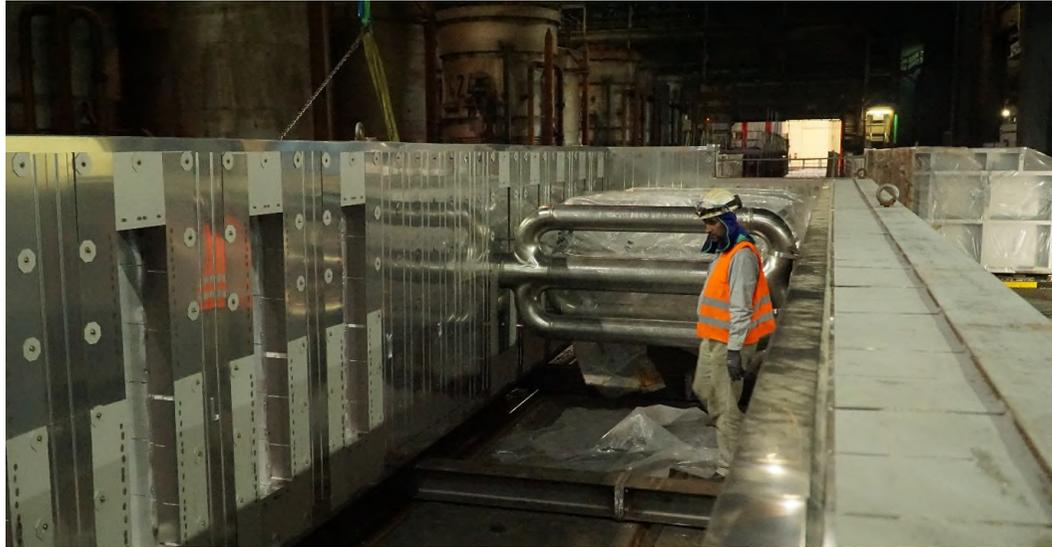
Einbau Module inkl. Isolierung
