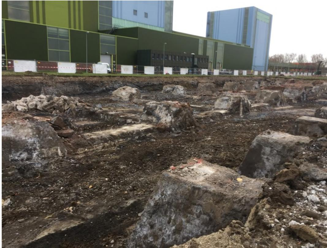
**Baufeldsanierung: Altfundamente einer Drahtstraße freigelegt.
